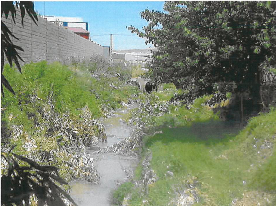
VERTIDO ACTUAL, CONEXIÓN COLECTOR P.V.C 1.100 MM DE D.
