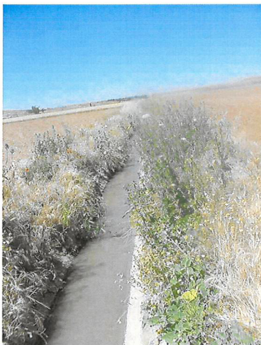
INICIO CANAL DE VERTIDO ACTUAL, TRAZADO COLECTOR DE LLEGADA P.V.C 315 MM D.
